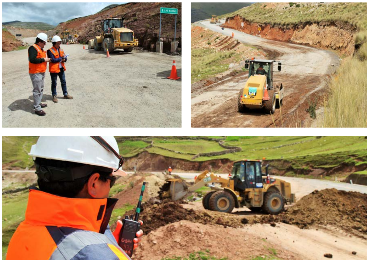
FIGURA N° 16 APERTURA DE LA VÍA PUMAMARCA QUEHUIRA, 18 DE ABRIL DEL 2017
